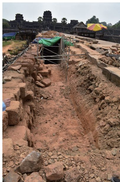
写真2. 棧橋修復の現場
