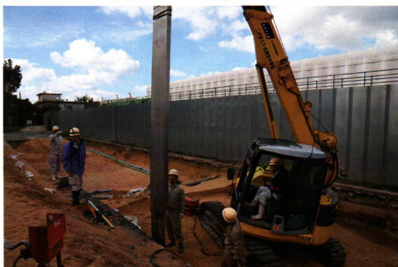
写真2. ジオスライサー調査 〔旧理学部二号館前南第2次調査(HZK1802)地点〕
